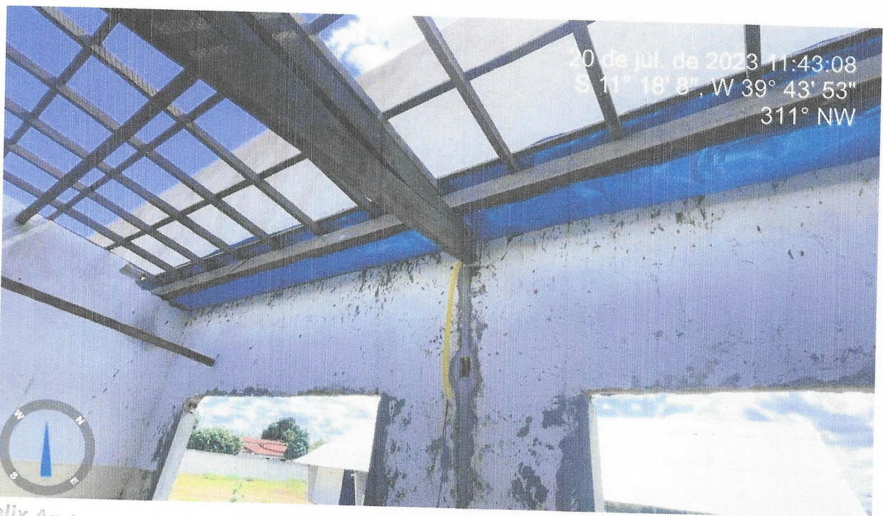
FOTO 04 - REVISÃO EM COBERTURA COM TELHA CERAMICA TIPO CANAL COMUM, ITABAIANA OU SIMILAR, COM REPOSIÇÃO DE 20% DO MATERIAL
