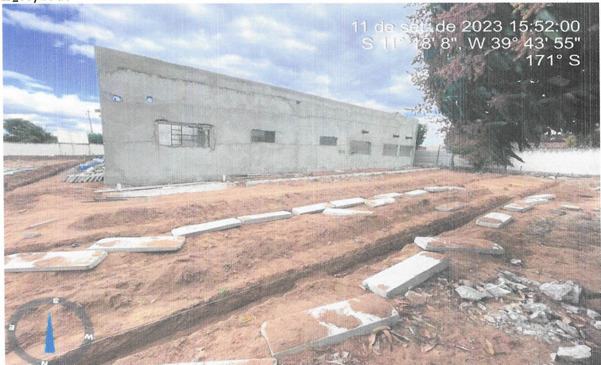
FOTO 18 - ATERRO MANUAL DE VALAS COM AREIA PARA ATERRO E COMPACTAÇÃO MECANIZADA. AF_05/2016
