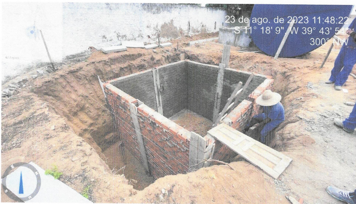
FOTO 16 - ALVENARIA DE BLOCOS 14X19X29 CM, (ESPESSURA 14 CM) FBK = 14,0 MPA, PARA PAREDES COM ÁREA LÍQUIDA MAIOR OU IGUAL A 6M 2 , COM VÃOS, UTILIZANDO COLHER DE PEDREIRO. AF_12/2014.
