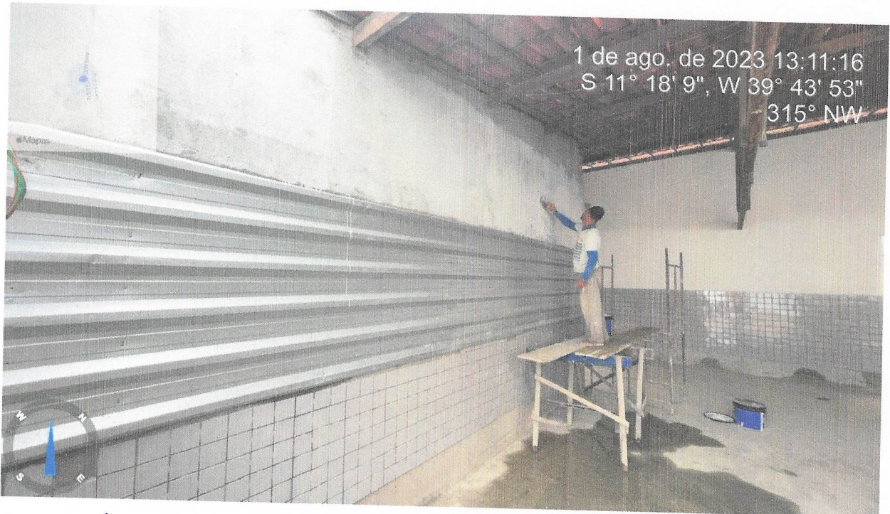
FOTO 10 - APLICAÇÃO MANUAL DE FUNDO SELADOR ACRÍLICO EM PAREDES EXTERNAS DE CASAS. AF_06/2014
