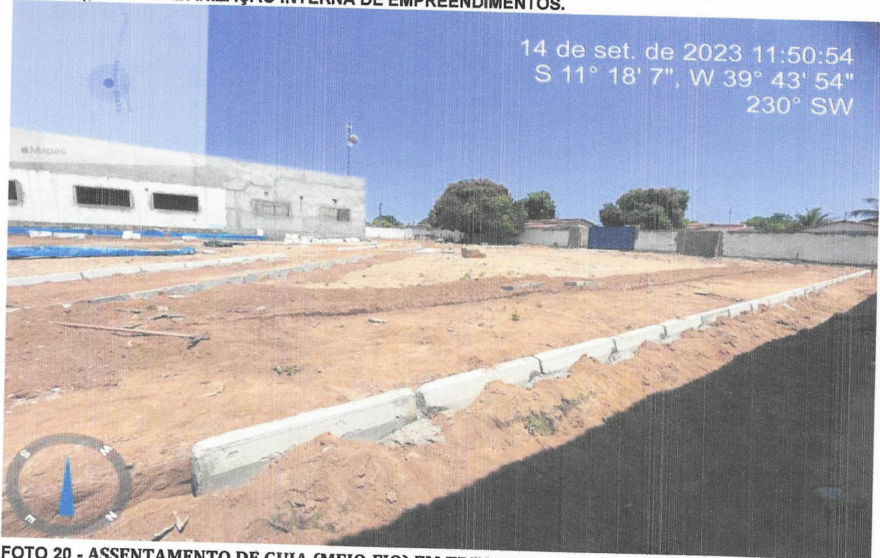
FOTO 20 - ASSENTAMENTO DE GUIA (MEIO-FIO) EM TRECHO CURVO, CONFECCIONADA EM CONCRETO PRÉ-FABRICADO, DIMENSÕES 100X15X13X20 CM (COMPRIMENTO X BASE INFERIOR X BASE SUPERIOR X ALTURA), PARA URBANIZAÇÃO INTERNA DE EMPREENDIMENTOS.
