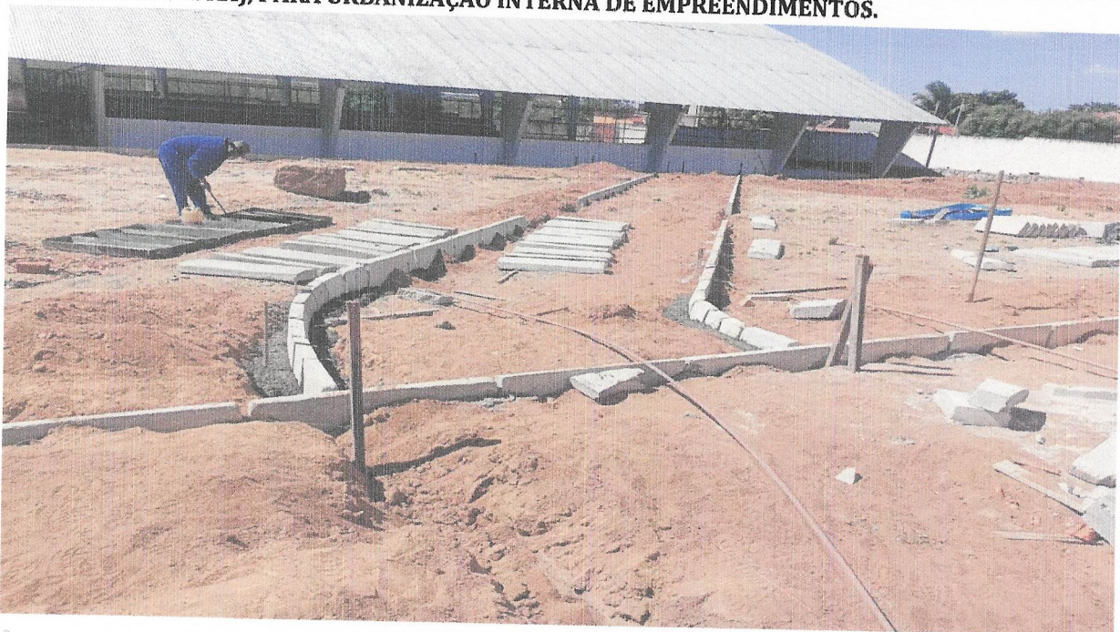
FOTO 20 - ASSENTAMENTO DE GUIA (MEIO-FIO) EM TRECHO CURVO, CONFECCIONADA EM CONCRETO PRÉ-FABRICADO, DIMENSÕES 100X15X13X20 CM (COMPRIMENTO X BASE INFERIOR X BASE SUPERIOR X ALTURA), PARA URBANIZAÇÃO INTERNA DE EMPREENDIMENTOS.
