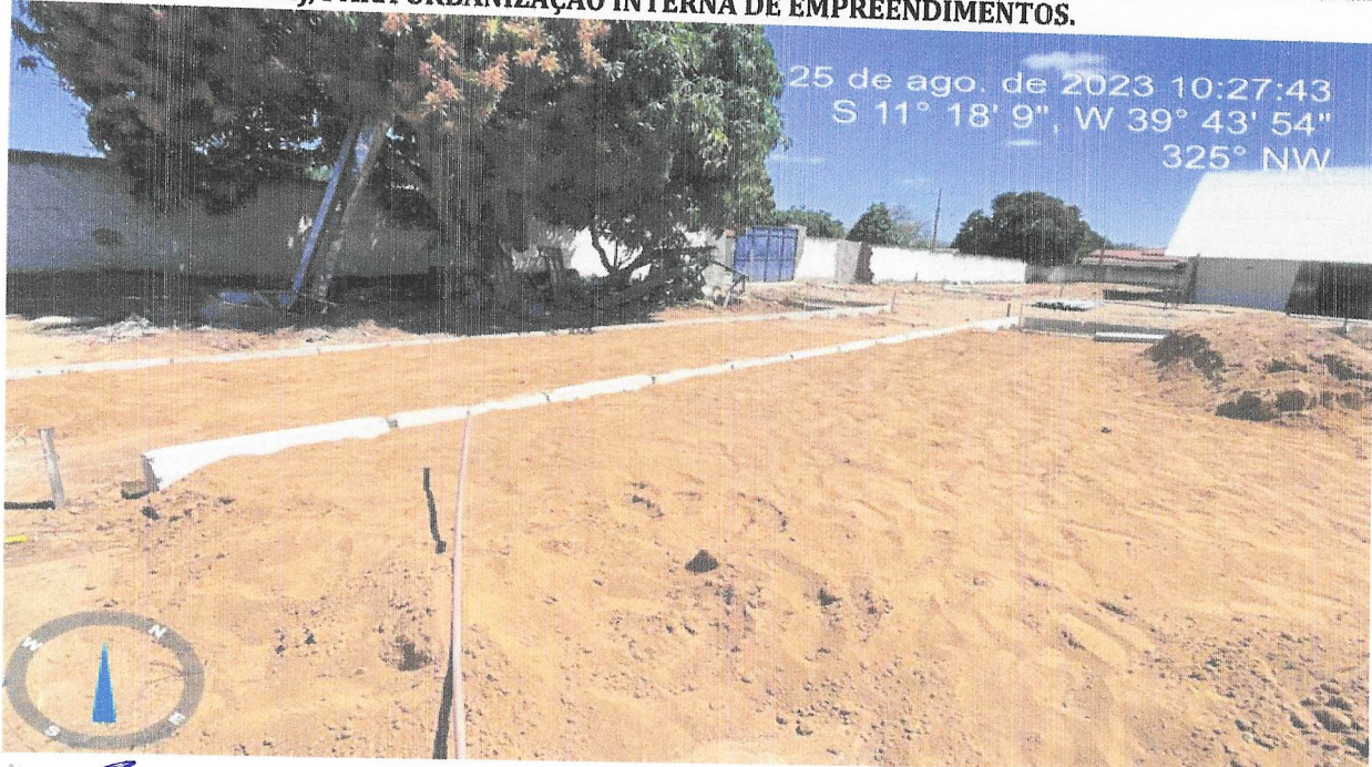
FOTO 22 - ASSENTAMENTO DE GUIA (MEIO-FIO) EM TRECHO RETO, CONFECCIONADA EM CONCRETO PRÉ-FABRICADO, DIMENSÕES 100X15X13X20 CM (COMPRIMENTO X BASE INFERIOR X BASE SUPERIOR X ALTURA), PARA URBANIZAÇÃO INTERNA DE EMPREENHIMENTOS.
