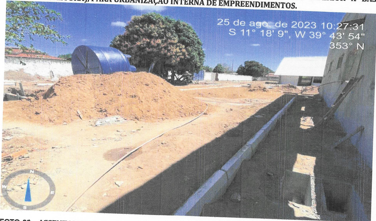
FOTO 22 - ASSENTAMENTO DE GUIA (MEIO-FIO) EM TRECHO RETO, CONFECCIONADA EM CONCRETO PRÉ-FABRICADO, DIMENSÕES 100X15X13X20 CM (COMPRIMENTO X BASE INFERIOR X BASE SUPERIOR X ALTURA), PARA URBANIZAÇÃO INTERNA DE EMPREENHIMENTOS.
