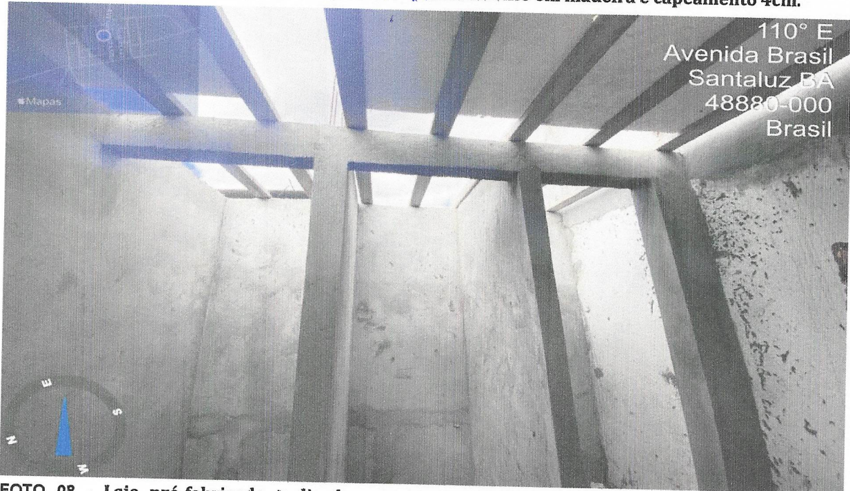
FOTO 08 - Laje pré-fabricada treliçada com vigota dupla para piso, intereixo 38cm, h=12cm, enchimento em bloco cerâmico h=8cm, inclusive escoramento em madeira e capeamento 4cm.
