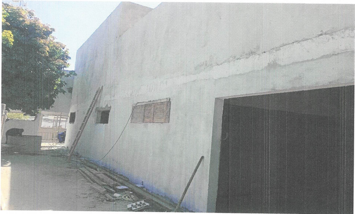
FOTO 12 - APLICAÇÃO E LIXAMENTO DE MASSA LÁTEX EM PAREDES, UMA DEMÃO.
