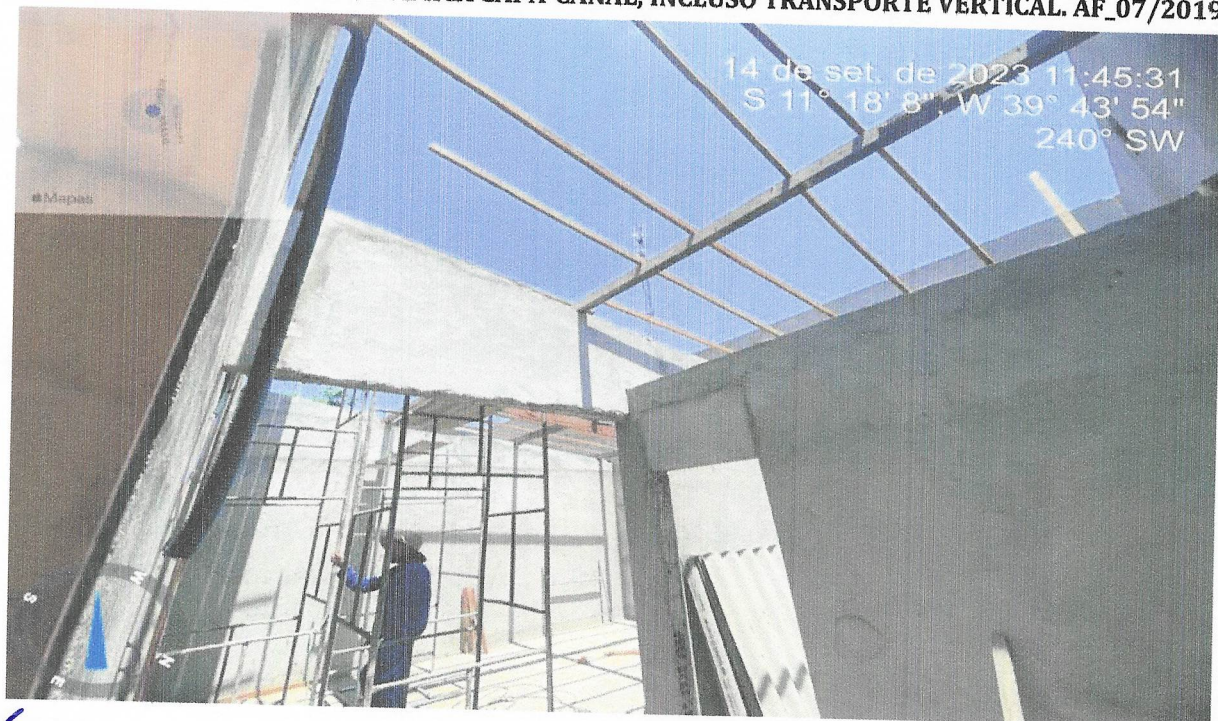
FOTO 02 - TRAMA DE MADEIRA COMPOSTA POR RIPAS, CAIBROS E TERÇAS PARA TELHADOS DE MAIS QUE 2 ÁGUAS PARA TELHA CERÂMICA CAPA-CANAL, INCLUSO TRANSPORTE VERTICAL. AF_07/2019
