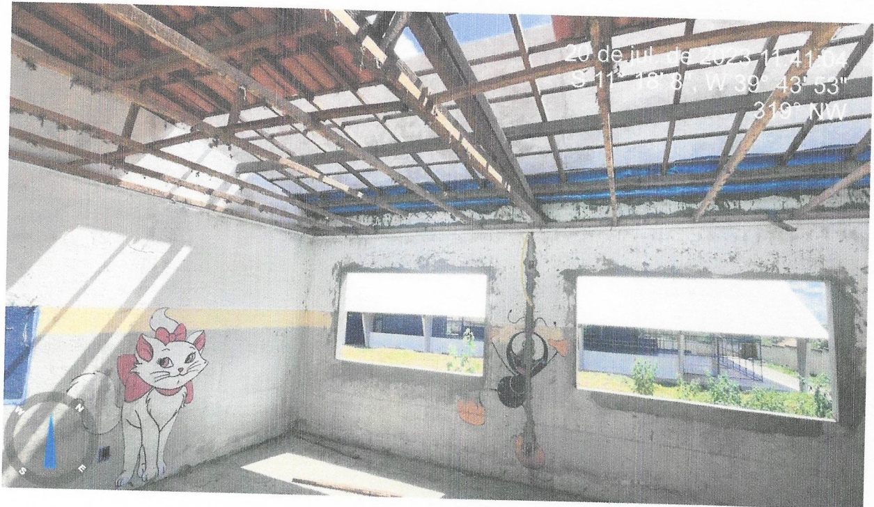
FOTO 06 - REVISÃO EM COBERTURA COM TELHA CERAMICA TIPO CANAL COMUM, ITABAIANA OU SIMILAR, COM REPOSIÇÃO DE 20% DO MATERIAL
