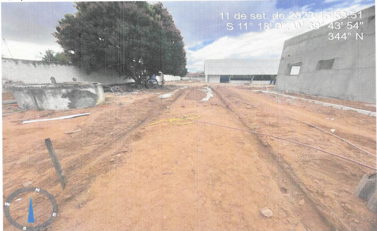
FOTO 18 - ATERRO MANUAL DE VALAS COM AREIA PARA ATERRO E COMPACTAÇÃO MECANIZADA. AF_05/2016
