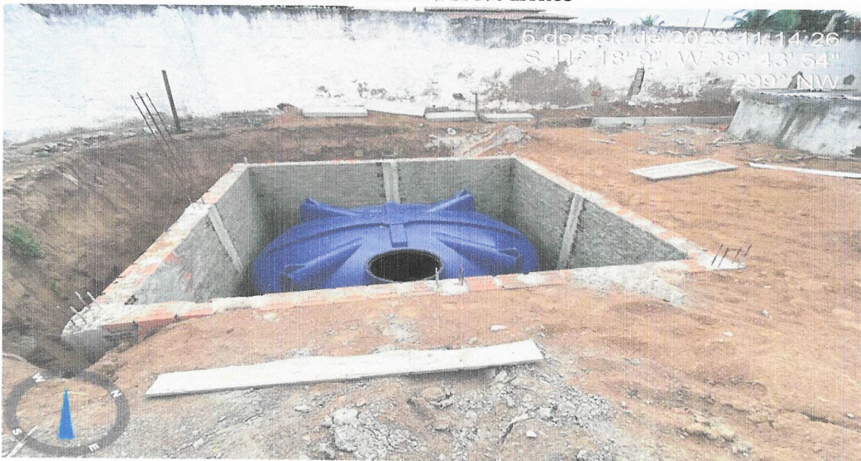
FOTO 16 - ALVENARIA DE BLOCOS 14X19X29 CM, (ESPESSURA 14 CM) FBK = 14,0 MPA, PARA PAREDES COM ÁREA LÍQUIDA MAIOR OU IGUAL A 6M 2 , COM VÃOS, UTILIZANDO COLHER DE PEDREIRO. AF_12/2014.
