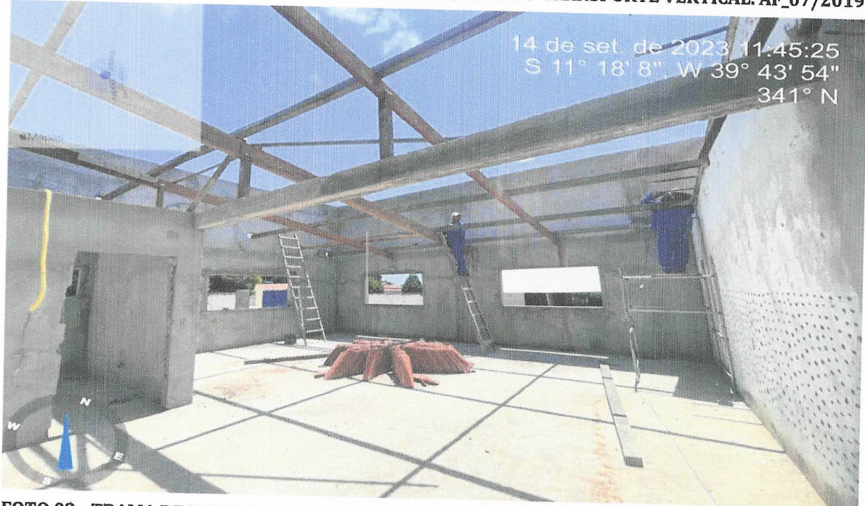
FOTO 02 - TRAMA DE MADEIRA COMPOSTA POR RIPAS, CAIBROS E TERÇAS PARA TELHADOS DE MAIS QUE 2 ÁGUAS PARA TELHA CERÂMICA CAPA-CANAL, INCLUSO TRANSPORTE VERTICAL. AF_07/2019
