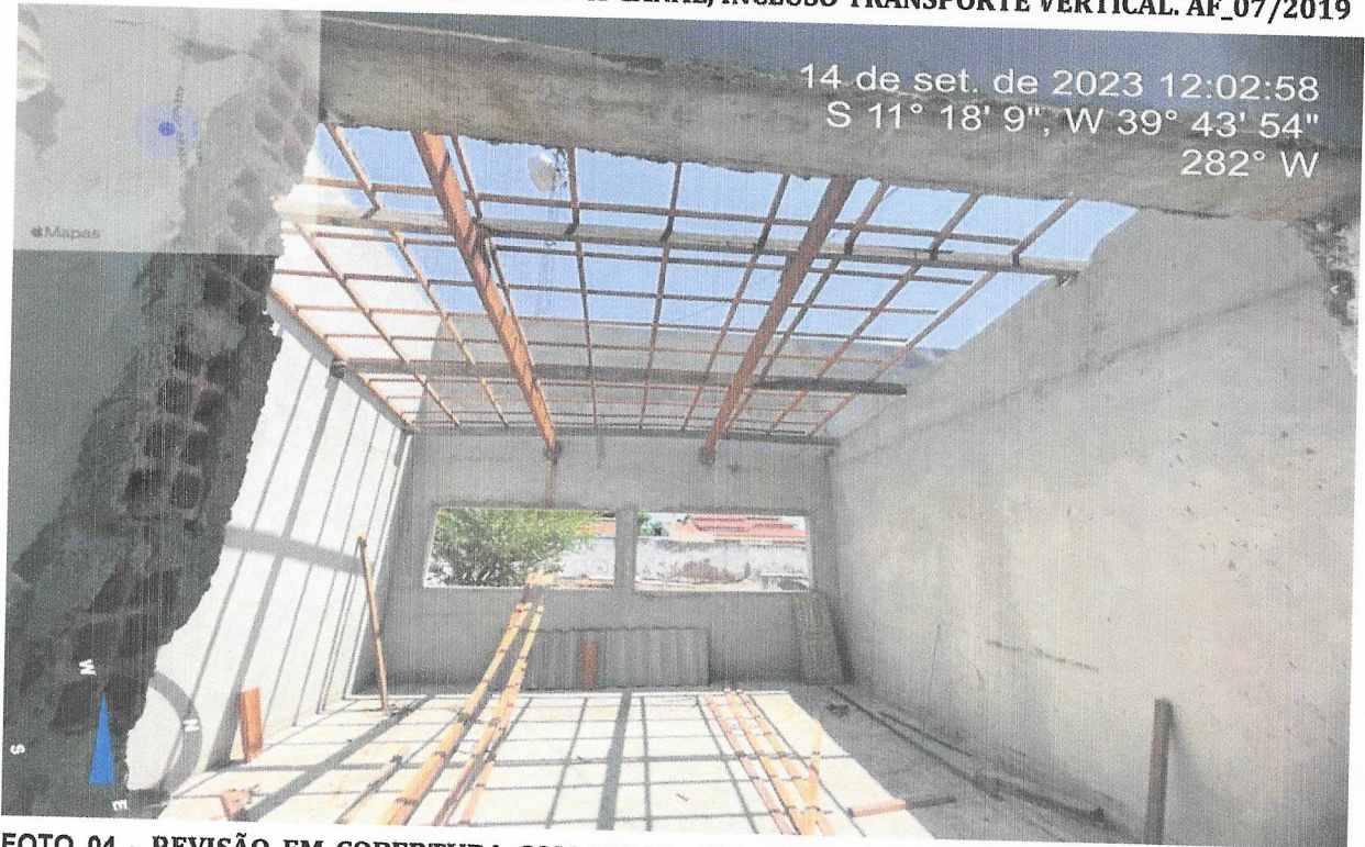
FOTO 04 - REVISÃO EM COBERTURA COM TELHA CERAMICA TIPO CANAL COMUM, ITABAIANA OU SIMILAR, COM REPOSIÇÃO DE 20% DO MATERIAL
